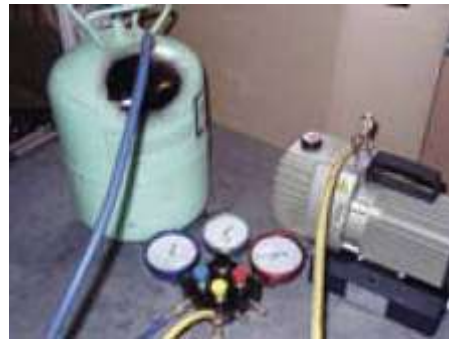
После остывания, закрасить место пайки и произвести Вакуумирование баллона через манометрический коллектор
